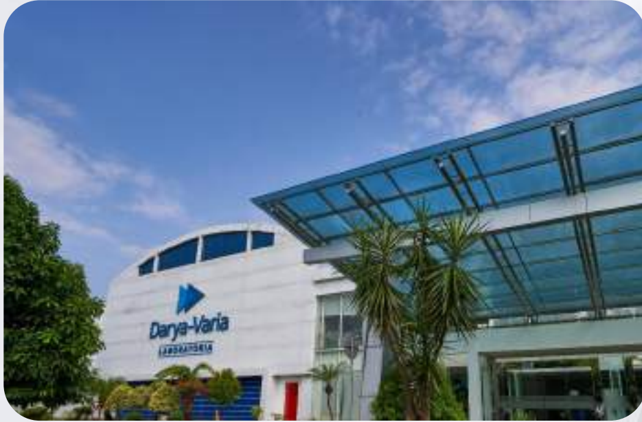
Gunung Putri Plant
