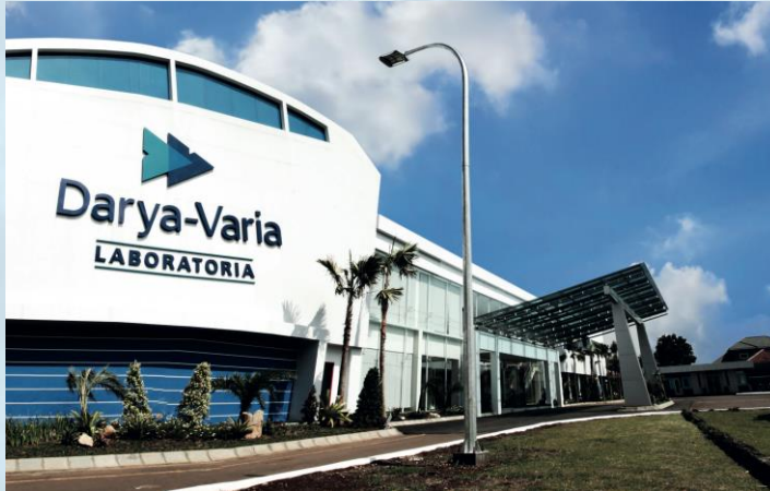
Pabrik Gunung Putri Gunung Putri Plant
